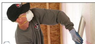
**Système d'isolation des murs ProPINK<sup>MD</sup>** : Isolant thermique en fibre de verre en vrac pour une installation dans des assemblages de murs ou de plafonds à l'aide d'un équipement pneumatique commercial, d'un matériau non tissé et de la jauge de densité Inspect-R<sup>MD</sup>. La résistance thermique dépend des dimensions de la cavité et de la densité de l'isolant soufflé.
