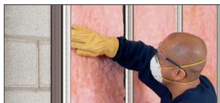
**Isolant thermique en matelas ROSE FIBERGLAS<sup>MD</sup> NOUVELLE GEN<sup>MC</sup>** : Isolant en matelas préformé, non revêtu et souple conçu pour une installation par friction dans des cavités en bois ou en acier. Il est offert en valeurs RSI (valeurs R) de 2.1 (R-12) à 9.5 (R-54), avec des épaisseurs allant de 89 mm (3 ½ pouces) à 406 mm (16 pouces).
