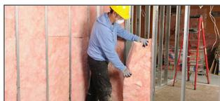
**Matelas insonorisants ROSE FIBERGLAS<sup>MD</sup> NOUVELLE GEN<sup>MC</sup> QUIÉTUDE<sup>MD</sup>** : Matériau absorbant le son pour divers assemblages intérieurs de planchers, de plafonds et de murs porteurs et non-porteurs à indice d'insonorisation et de résistance au feu. Conçu pour aider à contrôler la transmission du son en absorbant les vibrations sonores.
